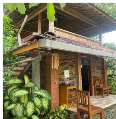
Gambar 6. Struktur Bangunan Kombinasi Kayu dan Bata Merah di Homestay Sungsang
